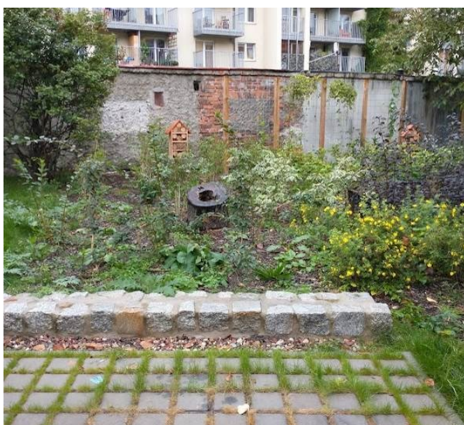
Ryc. 24. Nawierzchnia utwardzona przepuszczalna dla wody, wykonana z kostki betonowej.
