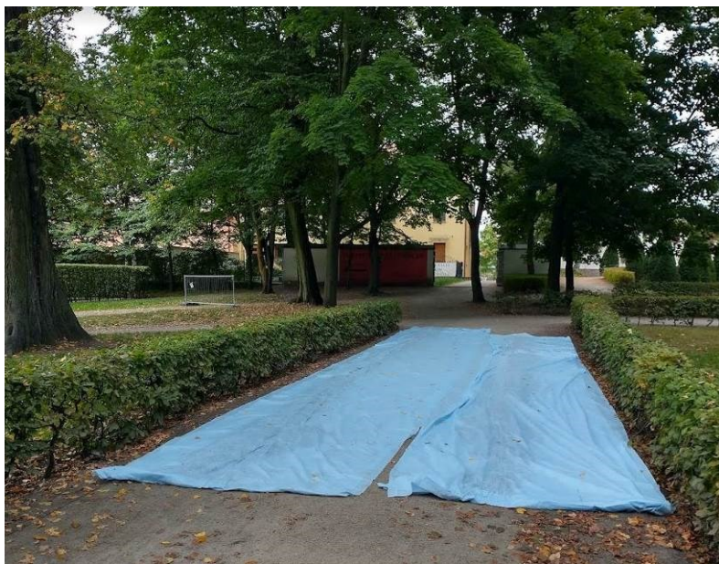
Ryc. 10. Zabezpieczenie korzeni w strefie ochrony drzewa - przykład ograniczenia nacisku na nawierzchnię w rejonie cennego drzewa.
