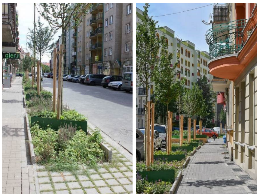
Ryc. 26. Przykład realizacji nowych nasadzeń i pasów zieleni w chodniku, które zatrzymują wody opadowe.
