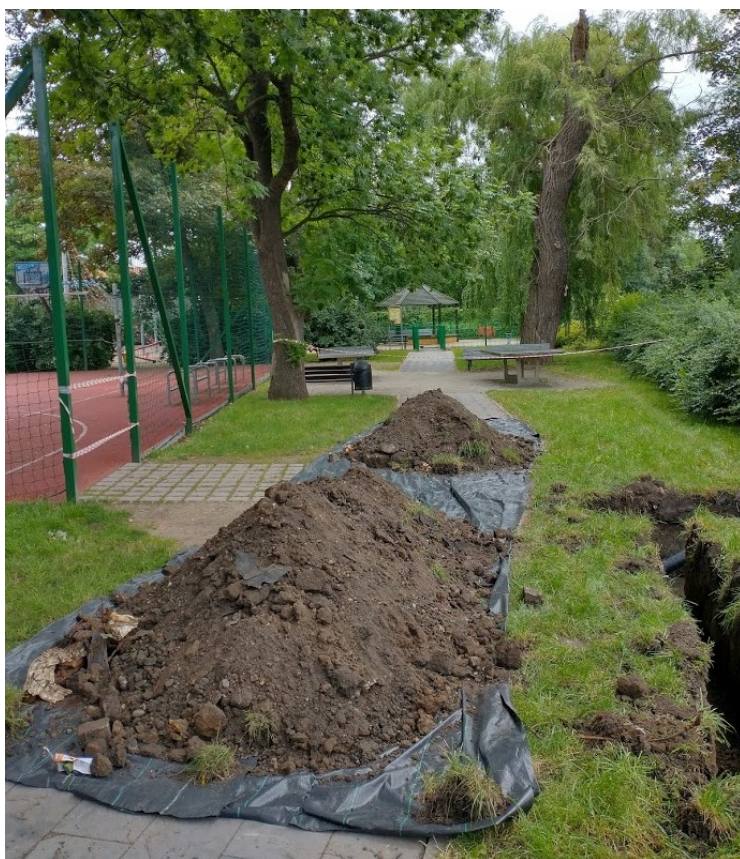
Ryc. 12. Przykład zabezpieczenia nawierzchni ciągu pieszego w czasie prowadzenia wykopu. (fot. Ł. Dworniczak)
