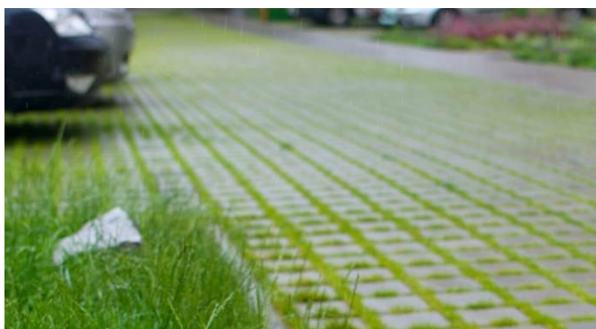
Ryc. 25. Nawierzchnie przepuszczalne z kostki betonowej na ciągach jezdnych i miejscach postojowych
