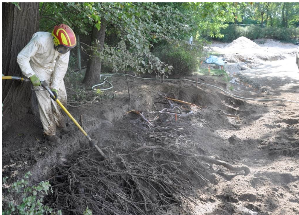
Ryc. 13. Odkrywanie systemu korzeniowego drzew za pomocą sprężonego powietrza. Fot. Maciej Motas (Arborysta.com)
