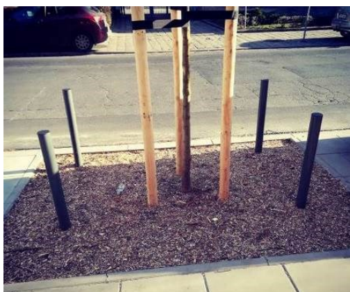
Ryc. 35. Zabezpieczenie powierzchni biologicznie czynnej za pomocą ograniczników wjazdu. Fot.. Piotr Drozda.
