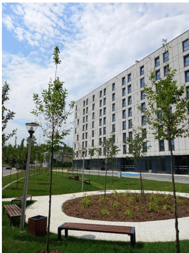
Budynek zamieszkania zbiorowego o funkcji usług hotelarskich oraz funkcji usługowej przy ul. Granicznej 32 (źródło: zdjęcia własne)
