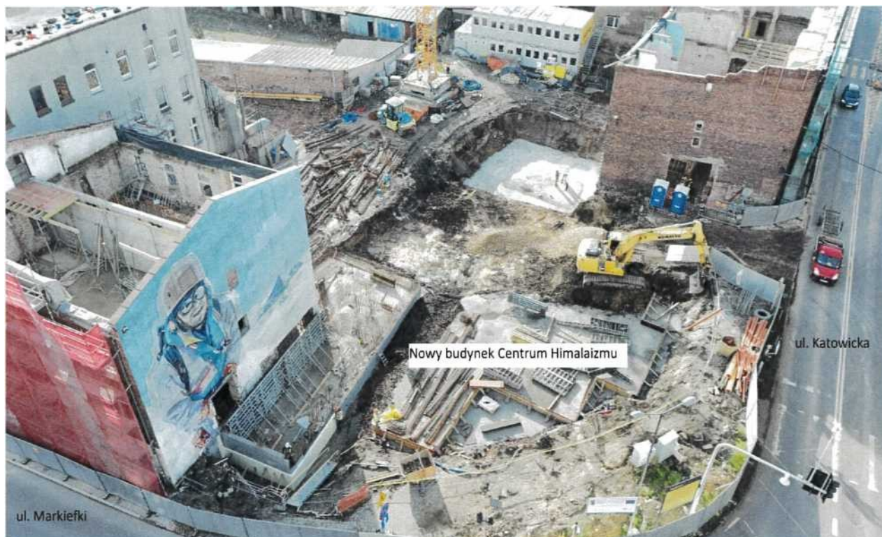
Fot. Stan budowy na dzień 5.11.2025 r.
