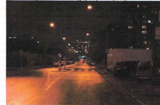
Rys. 9.14 Widok instalacji oświetleniowej – przykład 2 Źródło: Opracowanie własne
