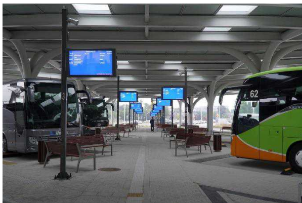
Centrum Przesiadkowe Sądowa, fot. M. Malina
