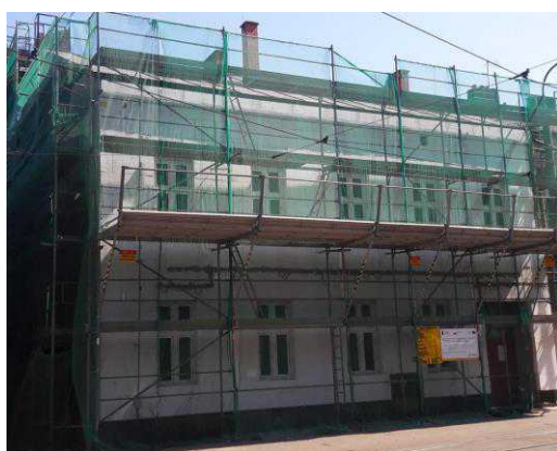
Prace termomodernizacyjne budynku
