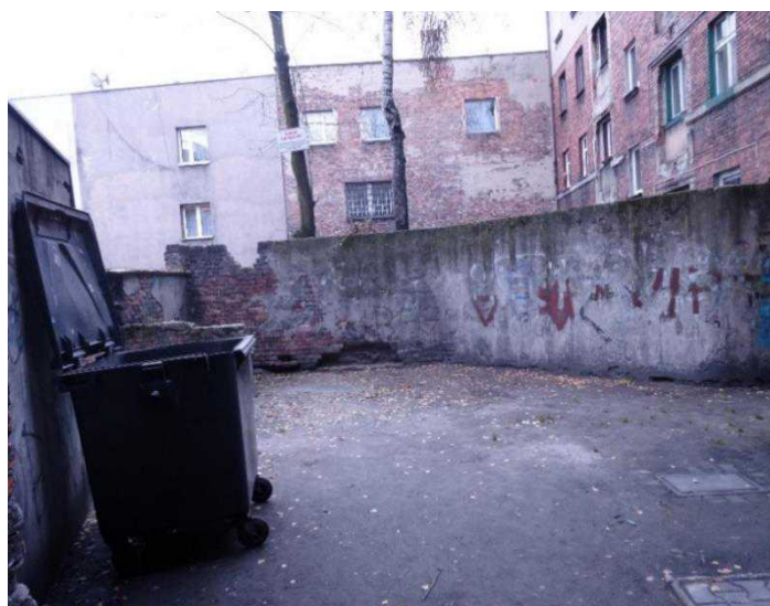
Karola 3 – przed modernizacją (1)
