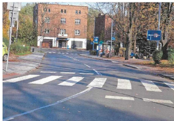
Ul. Zamkowa – po remoncie
