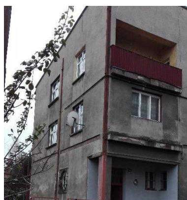
Zarębskiego 7a – przed modernizacją
