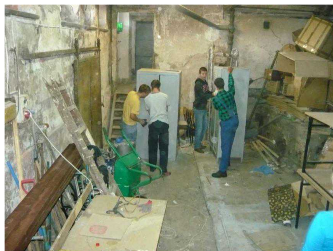
Pomieszczenie kotłowni - przed remontem (2)
