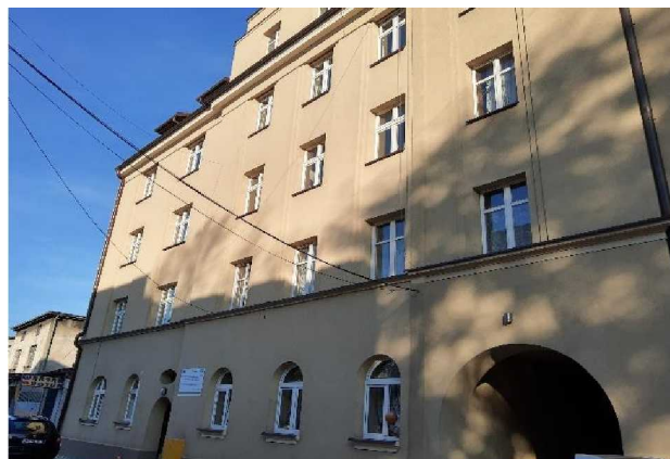
Zarębskiego 5a – budynek po modernizacji
