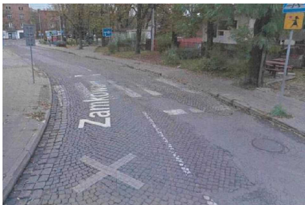
Ul. Zamkowa – przed remontem
