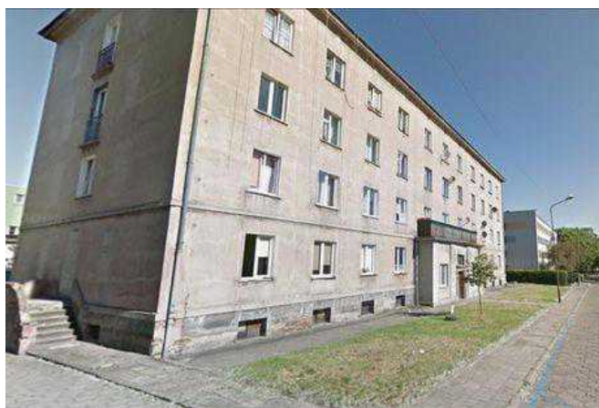
Wolnego 8 – budynek przed termomodernizacją
