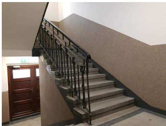
Wolnego 8 – klatka schodowa po modernizacji
