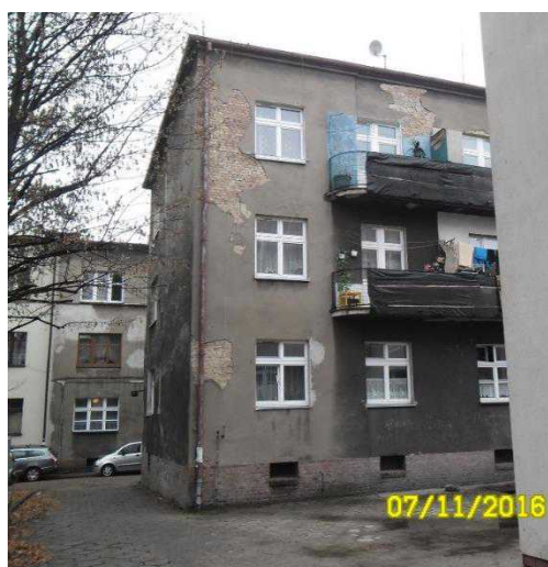
Szeligiewicza 3c – przed modernizacją
