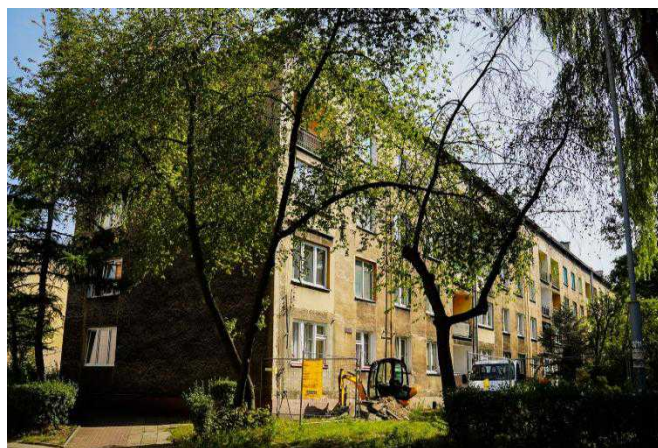
Wiosny Ludów 23-37 – budynek przed modernizacją
