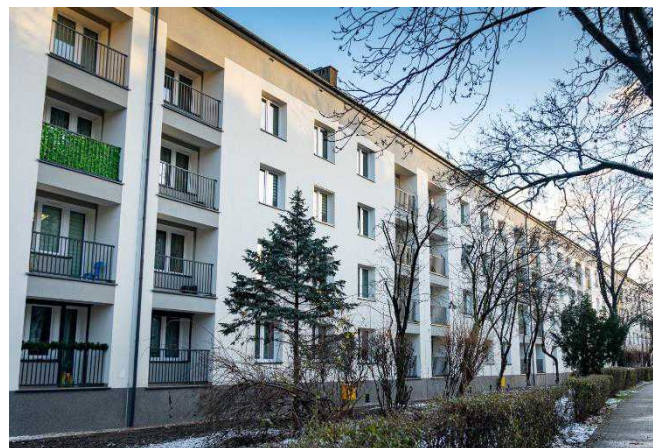
Wiosny Ludów 23-37 – budynek po modernizacji
