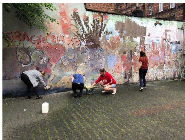
Rewitalizacja podwórka - czerwiec 2020
