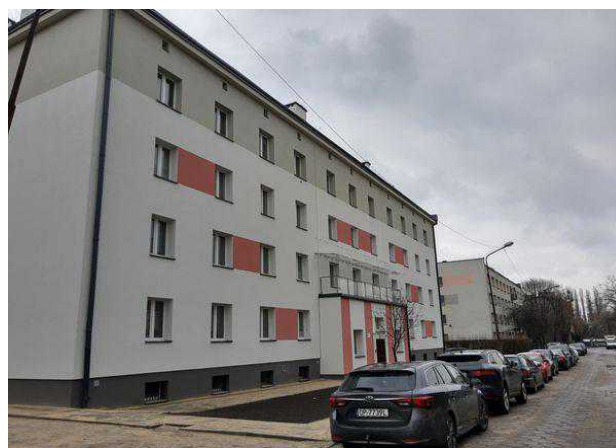
Wolnego 8 – budynek po termomodernizacji
