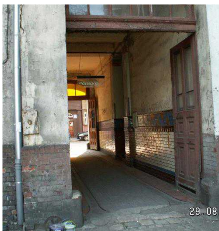
Gliwickska 13 – przed modernizacją (1)
